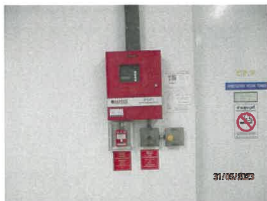
รูปที่ 38 ระบบเตือนภัย Fire Alarm Control Panel : FCP
