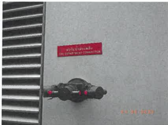
รูปที่ 34 หัวรับน้ำดับเพลิงภายนอกอาคาร
