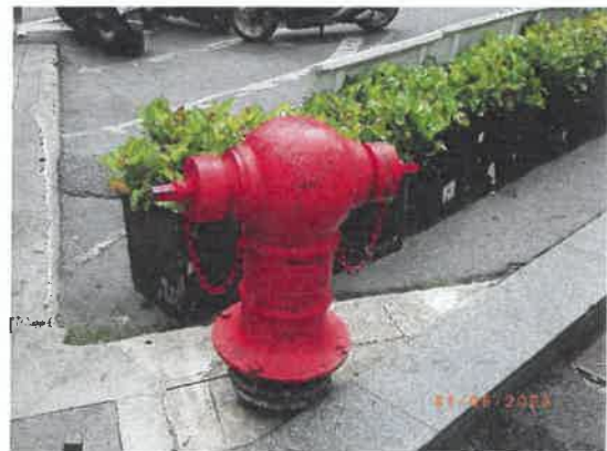
รูปที่ 34 หัวรับน้ำดับเพลิงภายนอกอาคาร
