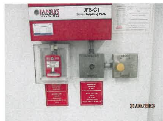
รูปที่ 38 ระบบเตือนภัย Fire Alarm Control Panel : FCP
