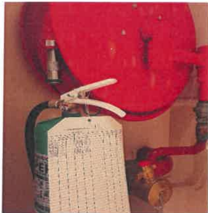
รูปที่ 44 ป้ายตรวจสอบอุปกรณ์ป้องกันอัคคีภัย
