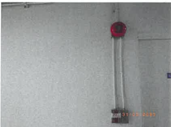
รูปที่ 40 กริ่งสัญญาณเตือนภัย (Alarm Bell)
